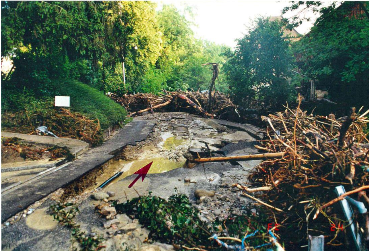
Foto: Holenstein Ingenieure AG, Peter Werner
