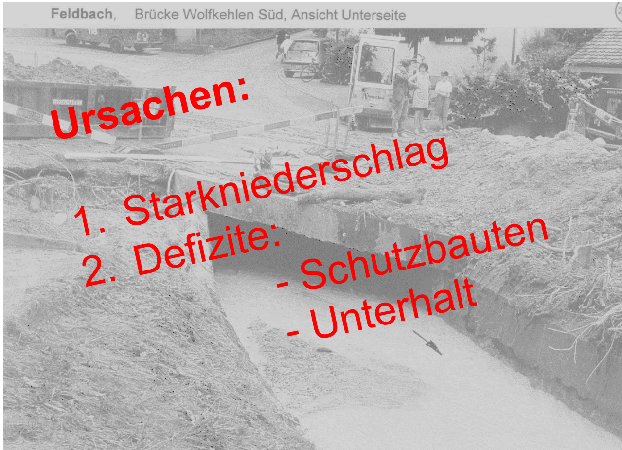
Foto: Holenstein Ingenieure AG, Peter Werner
